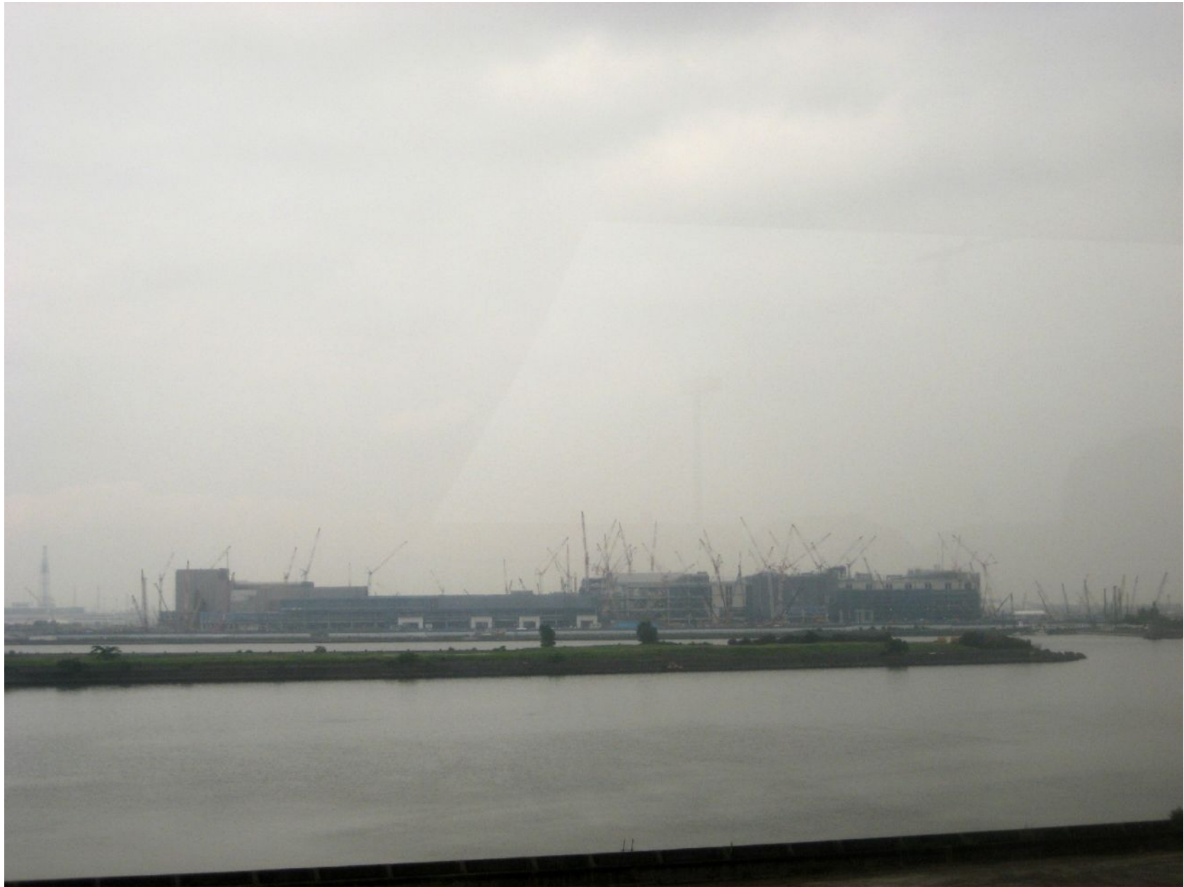
堺市臨海沖・建設中のシャープ工場
